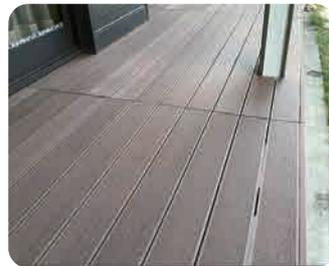
リブが付いたデッキ材なので専用クリップを使用した施工が可能です。クリップを使用することによりデッキ表面上にビスが出ないので、お子様やペットまで安心してご利用いただけます。
