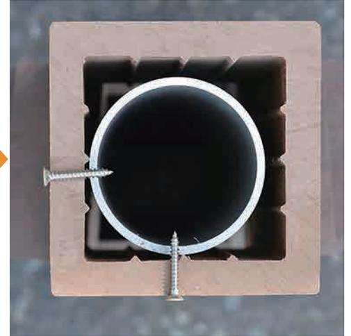
寄せた側の壁にしっかりと2カ所下穴をあけてビス止めしてください。アルミの下穴はビスの径-0.3mm程度、中空柱材の下穴はビスの径+0 ~ +1mm以上を推奨しています。ビスは25mm以上のものをご使用ください。
