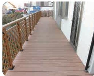
中空デッキ材は大胆な肉抜きで大幅な軽量化を実現しました。ベランダや屋根上などの重さが気になる場所や重量制限のある所でも安心してご利用いただけます。
