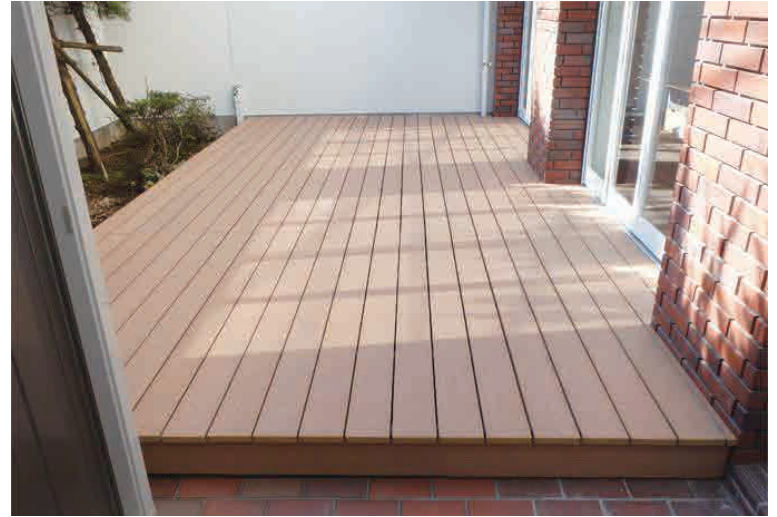
東京都大学内の一角にウッドデッキをご施工頂きました。大学内なので沢山の人が行き交う事を考慮しリブ付無垢デッキ材 (p.20) をご使用頂いています。
