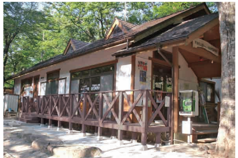
宮城県のキャンプ場「不動尊公園キャンプ場」の管理事務所のデッキ、ラティスです。いつ見ても色あせていない状態なのでキャンプ場を利用するお客様にも好印象ですね!
