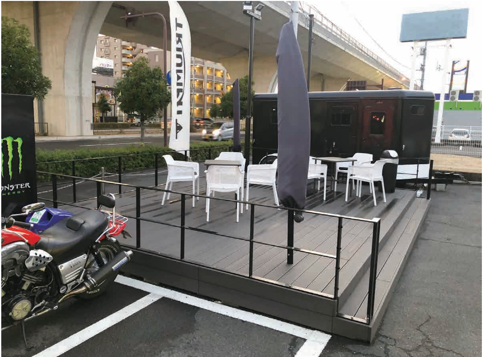
香川県にあるオートバイクメーカー「トライアンフ 香川」様にウッドデッキとしてご利用いただきました。店舗カラーに合わせたモダンブラックカラーを使用し、統一感ある仕上がりです。ご施工後お客様から大変好評だったので、他店舗にも追加でご施工頂きました。
