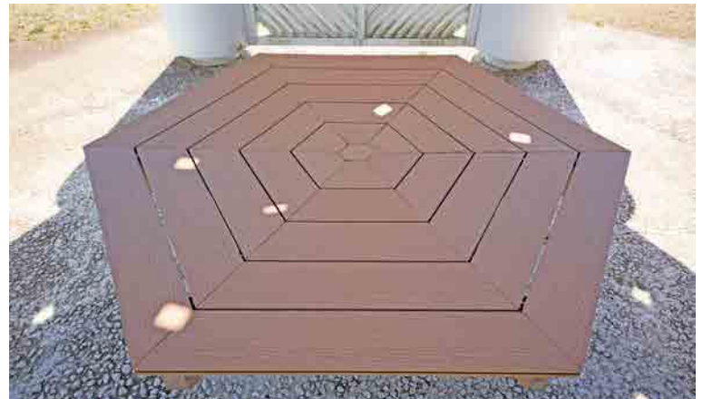
徳島県立公園内にご施工頂いた六角形のベンチをご施工頂きました。ご使用頂いたリブ付無垢デッキ材 (p.20) は天然木の様な複雑な加工もできます。
