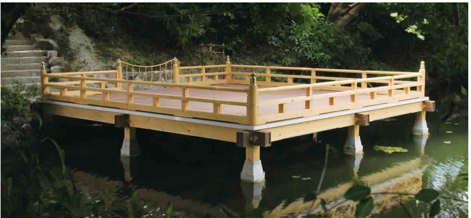
奈良県にある由緒正しい神社様に無垢デッキ材 (p.24) をご使用頂きました。神事や雅楽などにご使用いただいている水上舞台です。水にも強く高耐久デッキに仕上がっています。
