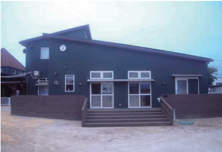
こども園のウッドデッキとフェンスをライトブラウンカラーの人工木でご施工頂きました。フェンスをこども目線の高さにしたり、ビスが表面に出ない仕上がりになっています。こども達が過ごしやすいよう考慮されているデザインです。
