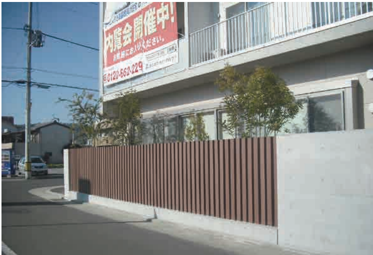
香川県内にある高齢者向け住宅のルーバーフェンスとしてご施工頂きました。中空柱材 (p.36) のHナチュラルを使用し、天然木のような風合いで仕上がっています。
