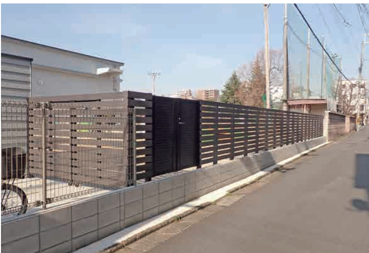
保育園全体を隠すフェンスとして無垢フェンス材 (p.30) をご使用頂いています。目地をしっかりと開けながらも、プライバシーを保護したデザインとなっています。圧迫感がなく園児が過ごしやすい環境に仕上がっています。
