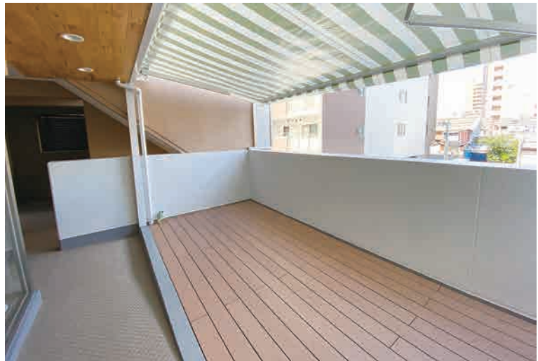
カラー:Hナチュラル 施工場所:ビルのテラス
