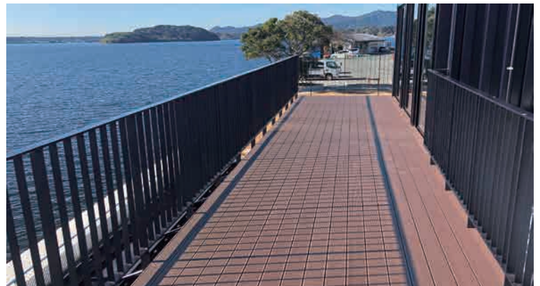
テラスデッキ
