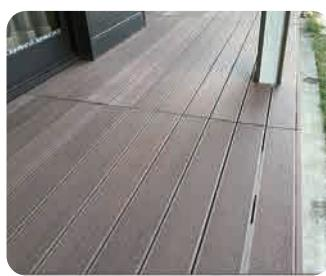
リブが付いたデッキ材なので専用クリップを使用した施工が可能です。
