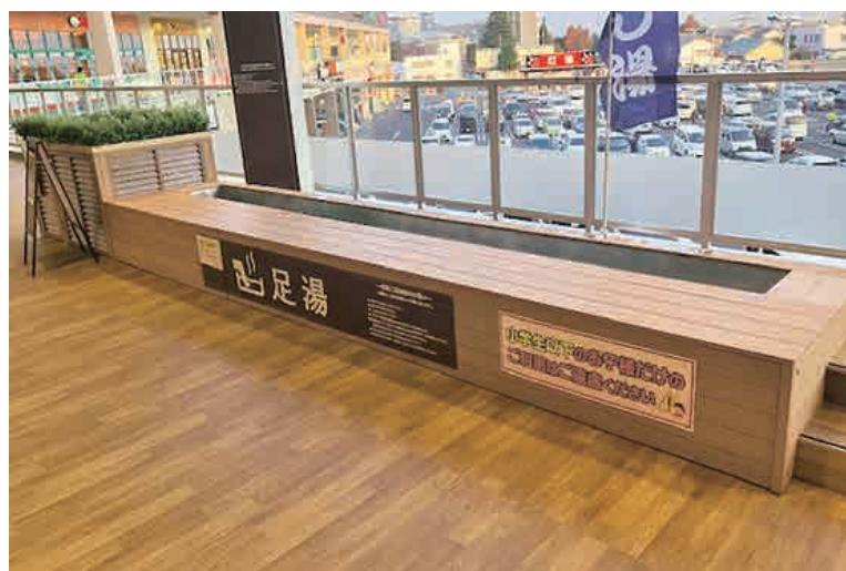
商業施設の一角にある足湯の座面と外装材として無垢デッキ材（p.24）ナチュラルをご使用いただきました。安全に使用できるよう角は丸みを帯びた加工を施しています。
