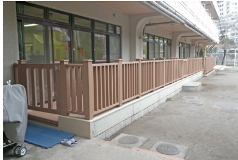
ナチュラルカラーを使用しているので、天然木の様な柔らかい仕上がりになっています。教育施設で人気のリップ付無垢デッキ材 (p.20) を使用し、お子様がビスで怪我をしない様な配慮もした仕上がりになっています。
