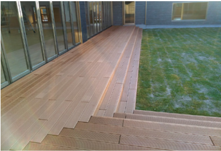
こども園のウッドデッキをナチュラルカラーの人工木でご施工頂きました。ウッドデッキの床材はビスが表面に出ない仕上がりになっているため、こども達が過ごしやすいよう考慮されているデザインです。
