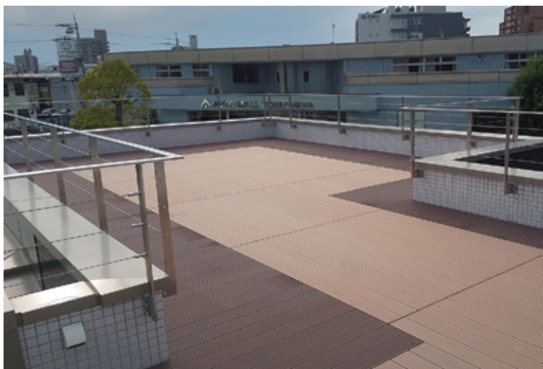
カラー：ナチュラル/ライトブラウン 施工場所：ショールーム屋上
