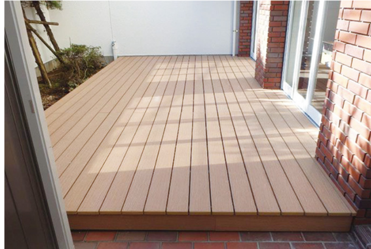
東京都大学内の一角にウッドデッキをご施工頂きました。大学内なので沢山の人が行き交う事を考慮しリップ付無垢デッキ材 (p.20) をご使用頂いています。
