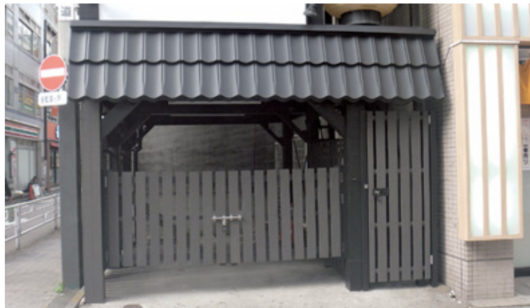
上野6丁目防犯センターの外装材として無垢フェンス材 (p.30) のモダンブラックをご使用頂きました。施工後も塗装不要なのでメンテナンスをしなくても美観を保てます。
