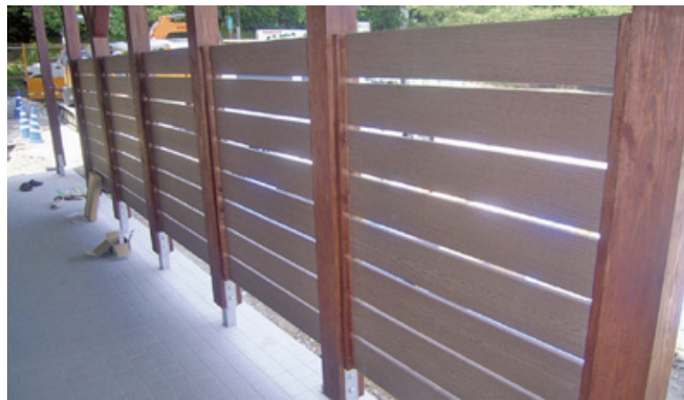
熊本県にある上天草市千歳山の公衆トイレの目隠しフェンスとしてご施工頂きました。施工後の塗装等のメンテナンスを考慮し、人工木をお選びいただきました。
