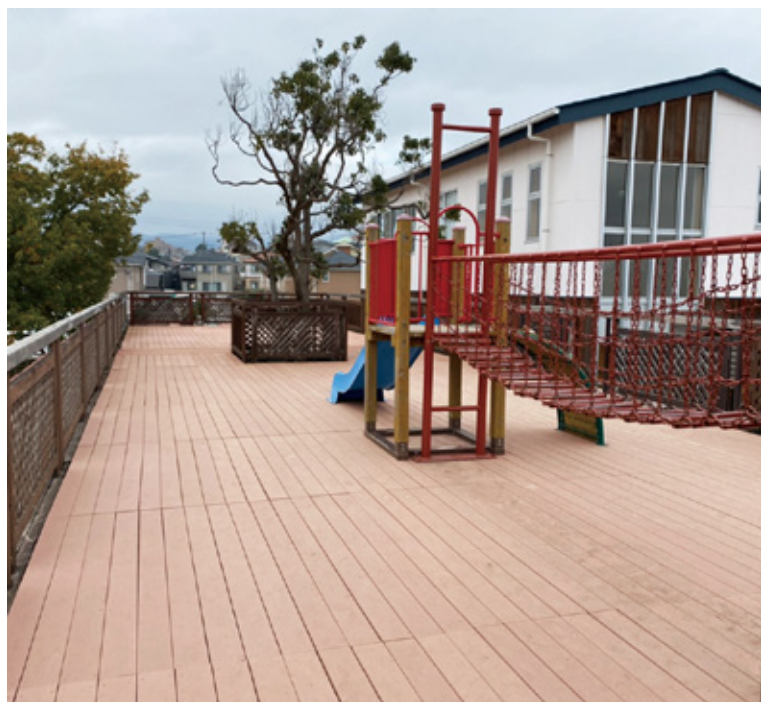
幼稚園の屋上デッキを天然木から人工木材にリフォームして頂きました。人工木材は耐候性が強いので紫外線や雨風の影響を受けやすい屋上に最適です。
