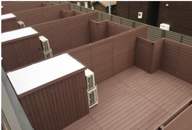
千葉県にある共同施設のウッドデッキ・フェンス・物置の外装材としてご施工頂きました。全てライトブラウンカラーを使用した、統一感のある仕上がりになっています。
