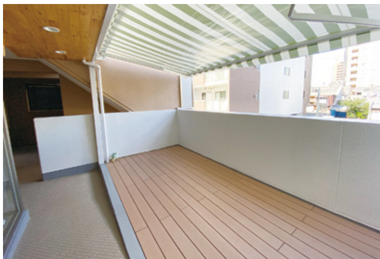
カラー：ナチュラル 施工場所：ビルのテラス
