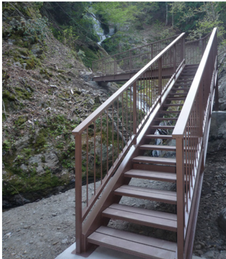
京都丹波高原国定公園内にある階段の床材として無垢デッキ材 (p.24) をご使用頂きました。自然の中でも天然木の様な風合いがしっかりと景観に馴染んでいます。
