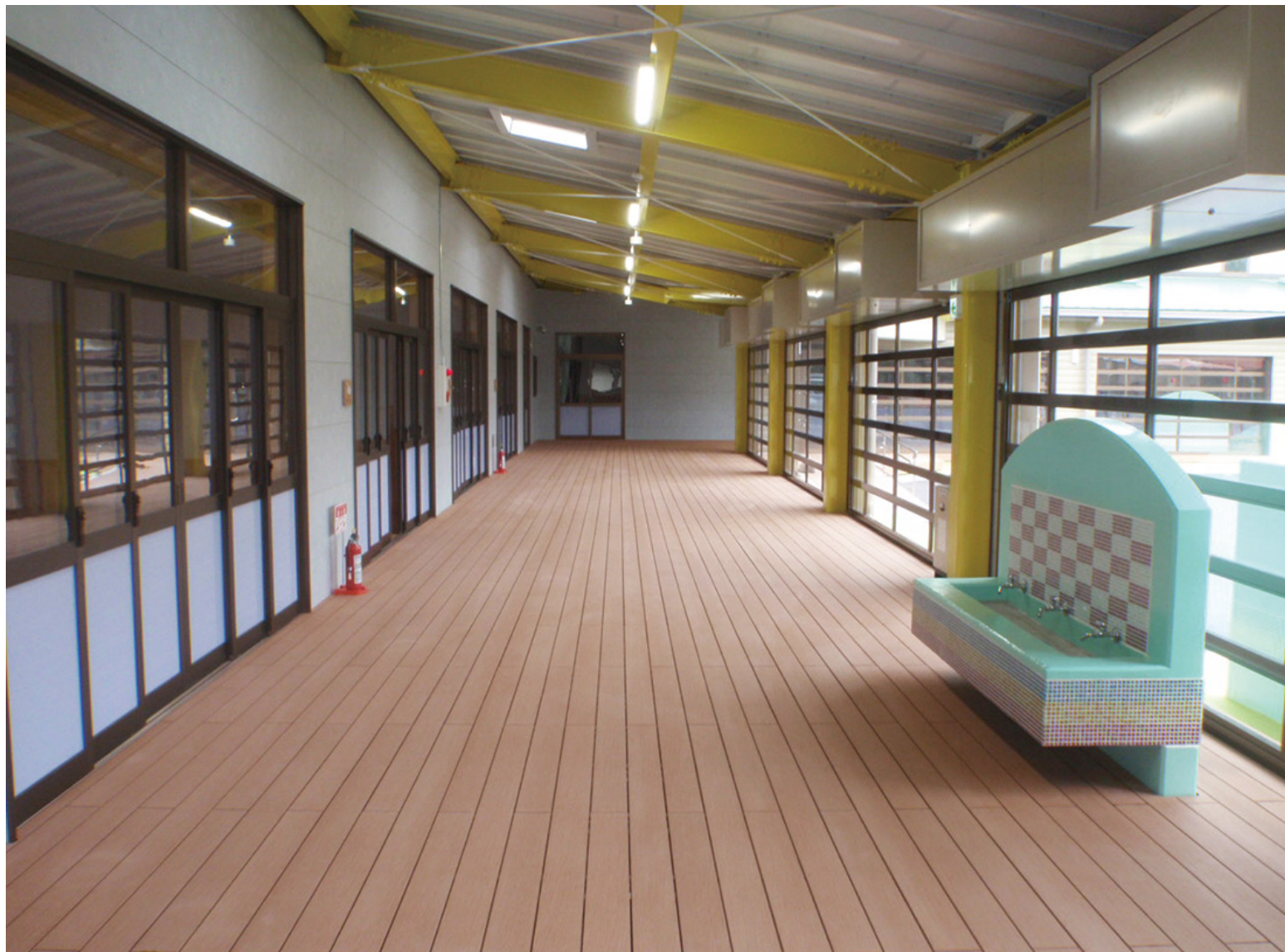
こども園に 300 m以上のウッドデッキをご施工頂きました。広々とした空間を全てフラットにしたウッドデッキはササクレしないので、お子様が元気いっぱい走り回っても安全です。また、中空デッキ材 (p.26) を使用しているのでビスが表面に出ないクリップ施工で仕上げています。ナチュラルカラーを使用。
