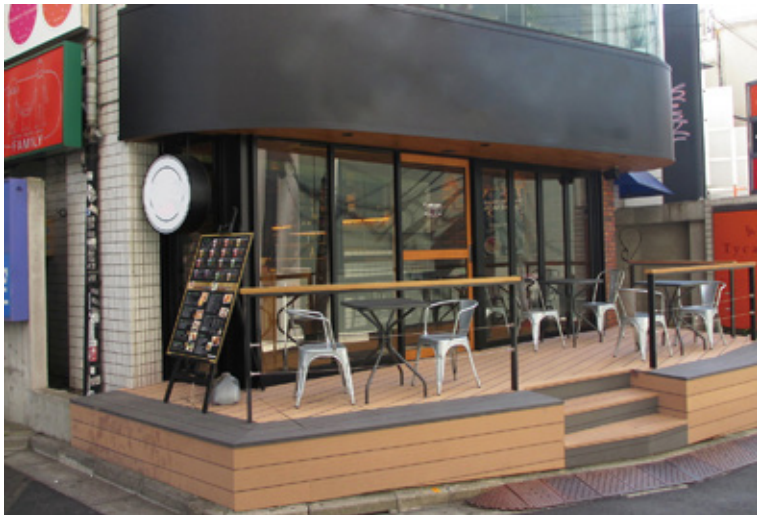
カフェのウッドデッキにご使用いただきました。ナチュラルとモダンブラックの2色を使用したアクセントあるデザインに!
