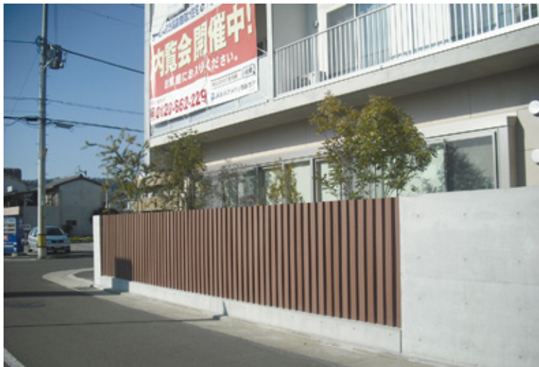
香川県内にある高齢者向け住宅のルーバーフェンスとしてご施工頂きました。中空柱材 (p.36) のナチュラルを使用し、天然木の様な風合いで仕上がっています。
